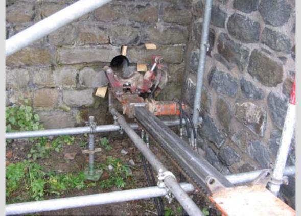
Bohrlafette des Kernbohrgerätes
