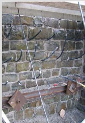
Verpressarbeiten mit Injektionsschaumörtel
