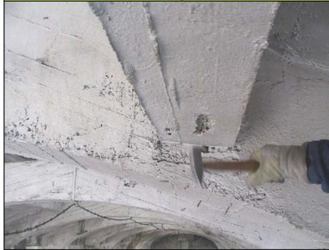
Schadensstufe 2 - Längsbalken B - 2/3
