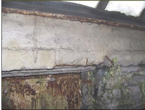
Schadensstufe 3 - Längsbalken D - 2/3
