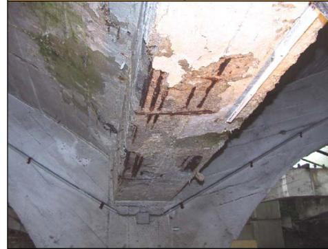
Schadensstufe 4 - Längsbalken D - 4/5
